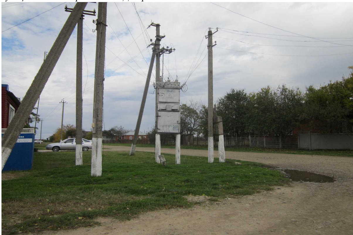
Трансформаторная подстанция -100 кВт. ул. Чапаева и Андрухаева. Скрутки. Надписей нет. Непокрашен.
