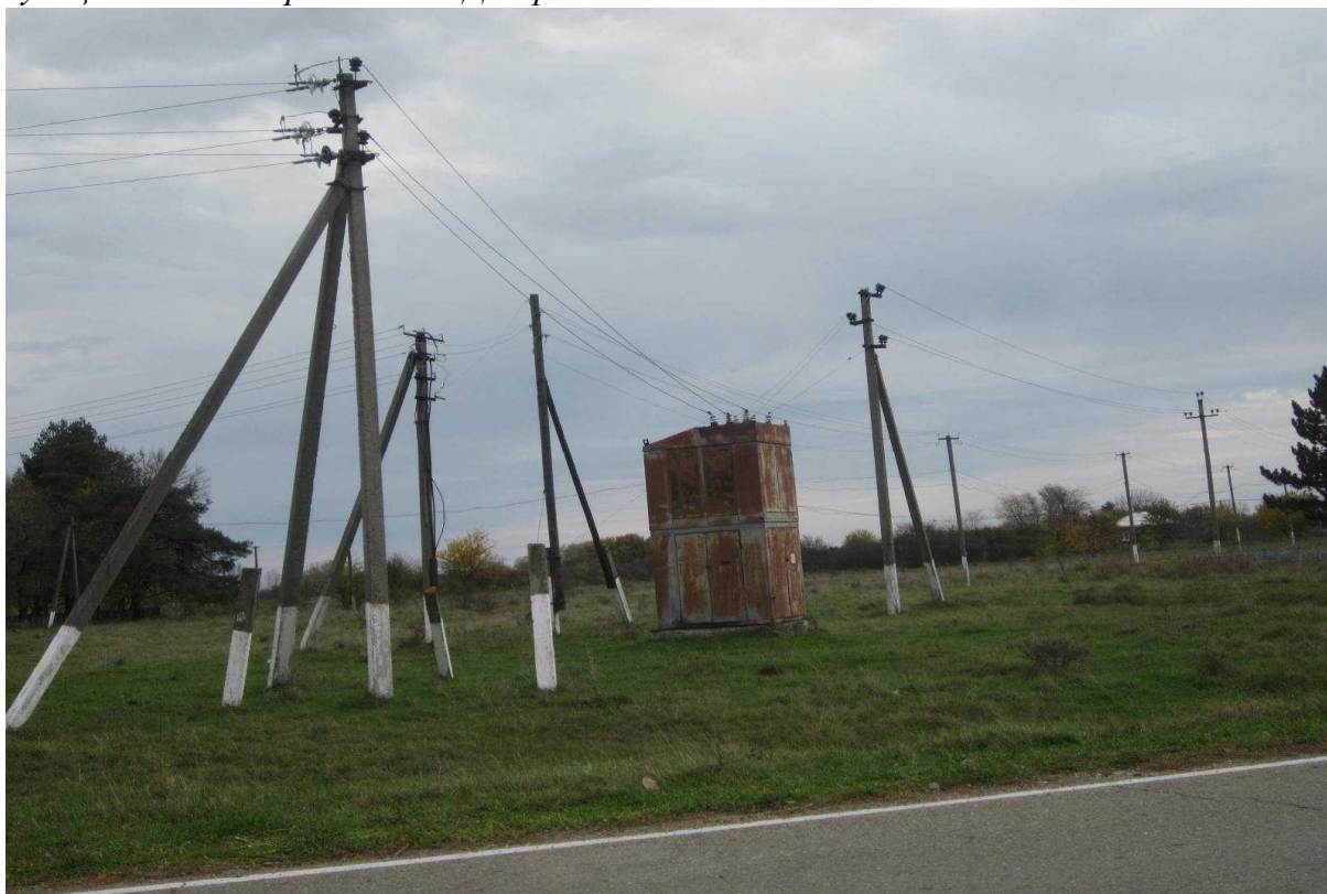
Трансформаторная подстанция -250 кВт. х.Свободный Труд. Ул.Шоссейная. ТП ржавый. Надписей нет.
