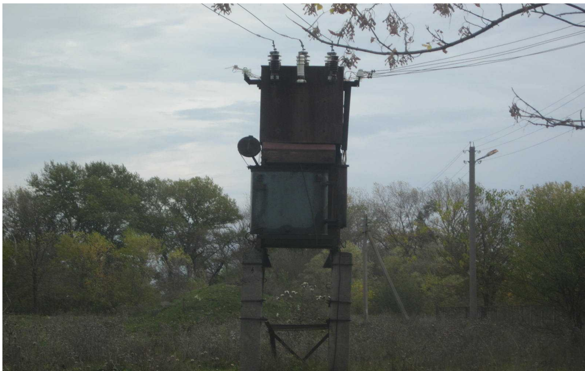
Трансформаторная подстанция-100 кВт. ТП ржавый. Замаслен. Надписей нет.
