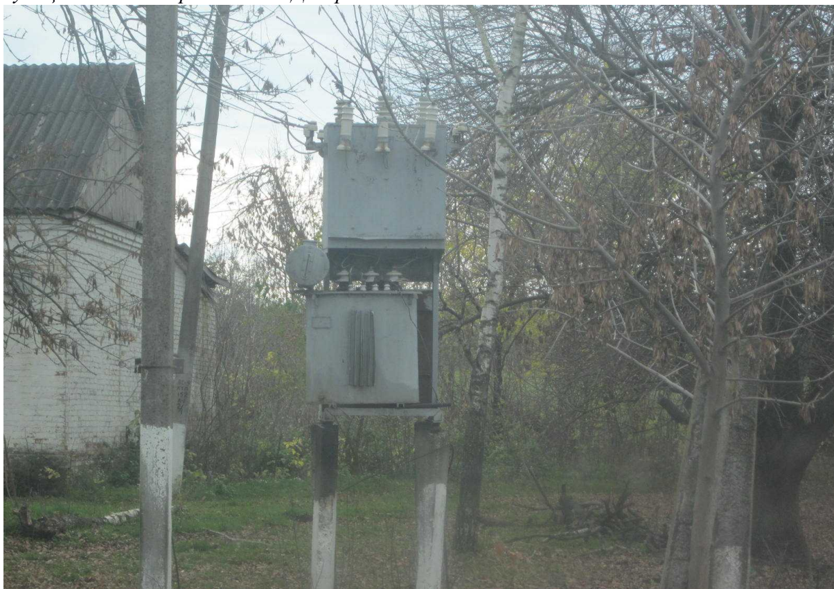
Трансформаторная подстанция -100 кВт. Замаслен. Нет надписей.
