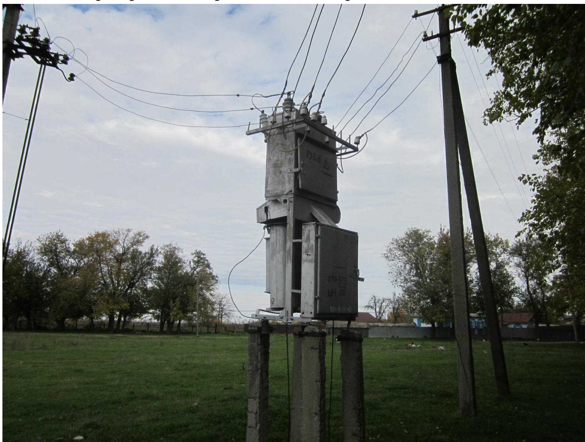
Трансформаторная подстанция – 100 кВт. ул. Садовая. ТП ржавый. Надписей нет. Столбы не покрашены.
