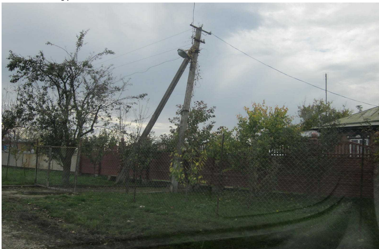
Линия электропередач. ул. Чапаева. Столб весь зарос. Стоит криво.
