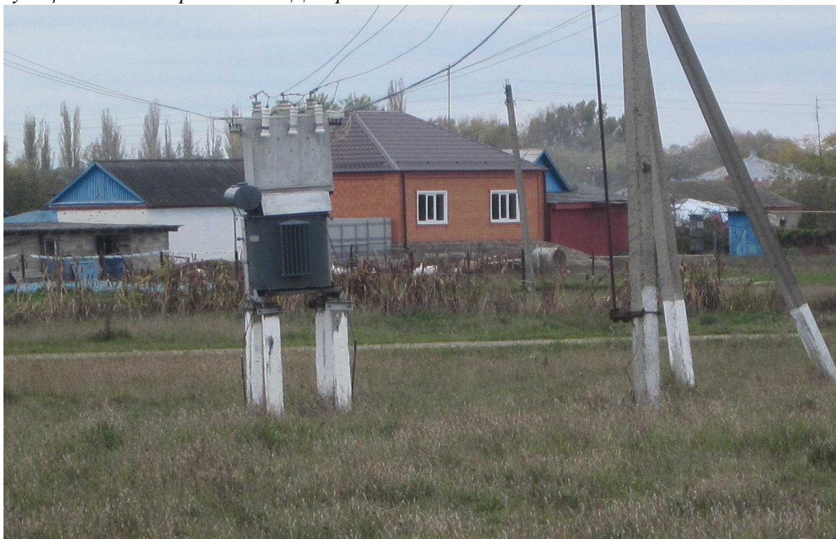
Трансформаторная подстанция-100 кВт. ул.Гагарина. ТП ржавый. Надписей нет.
