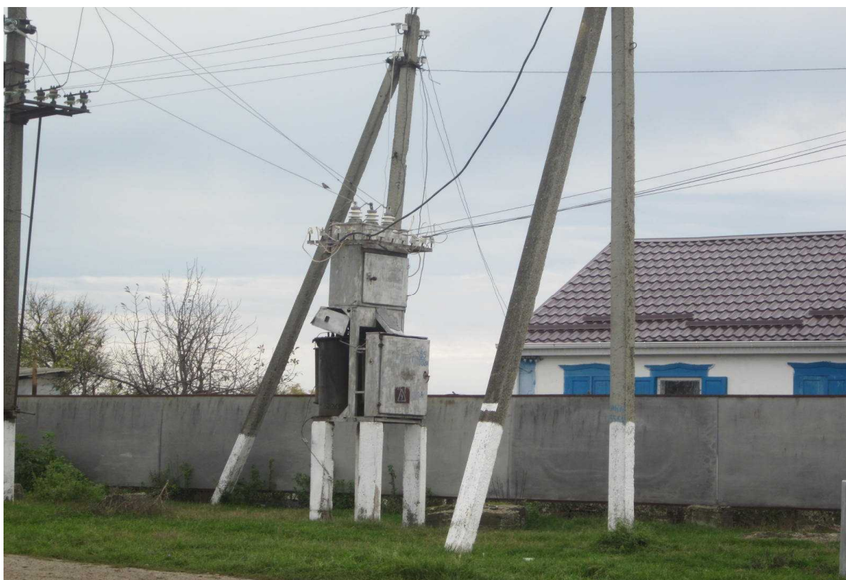
Трансформаторная подстанция-160 кВт. ул.Гагарина-Красная. ТП замаслен. Надписей нет. Ржавый.
