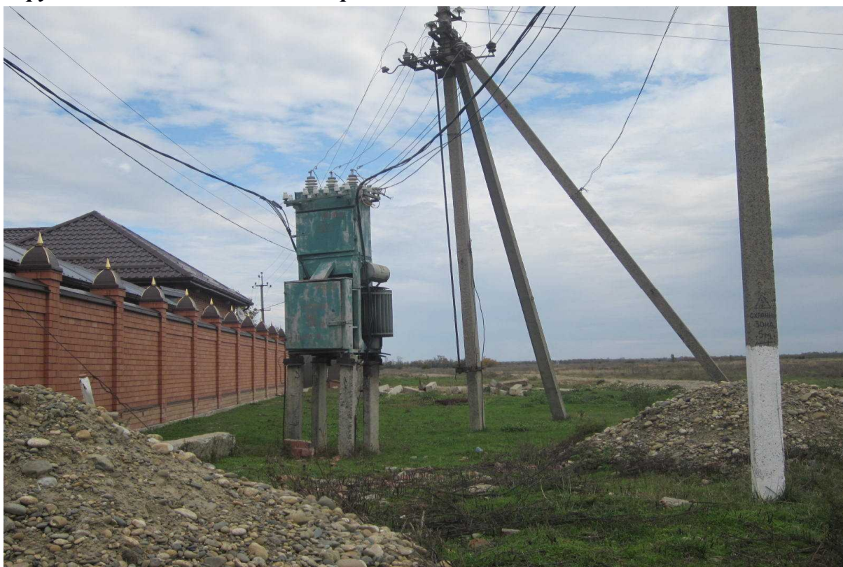
Трансформаторная подстанция -100 кВт. ул.Шовгенова. Не покрашен. Ржавый. Надписей нет.
