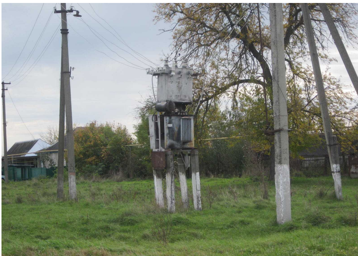
Трансформаторная подстанция-100 кВт. ТП ржавый. Замаслен. Нет надписей.
