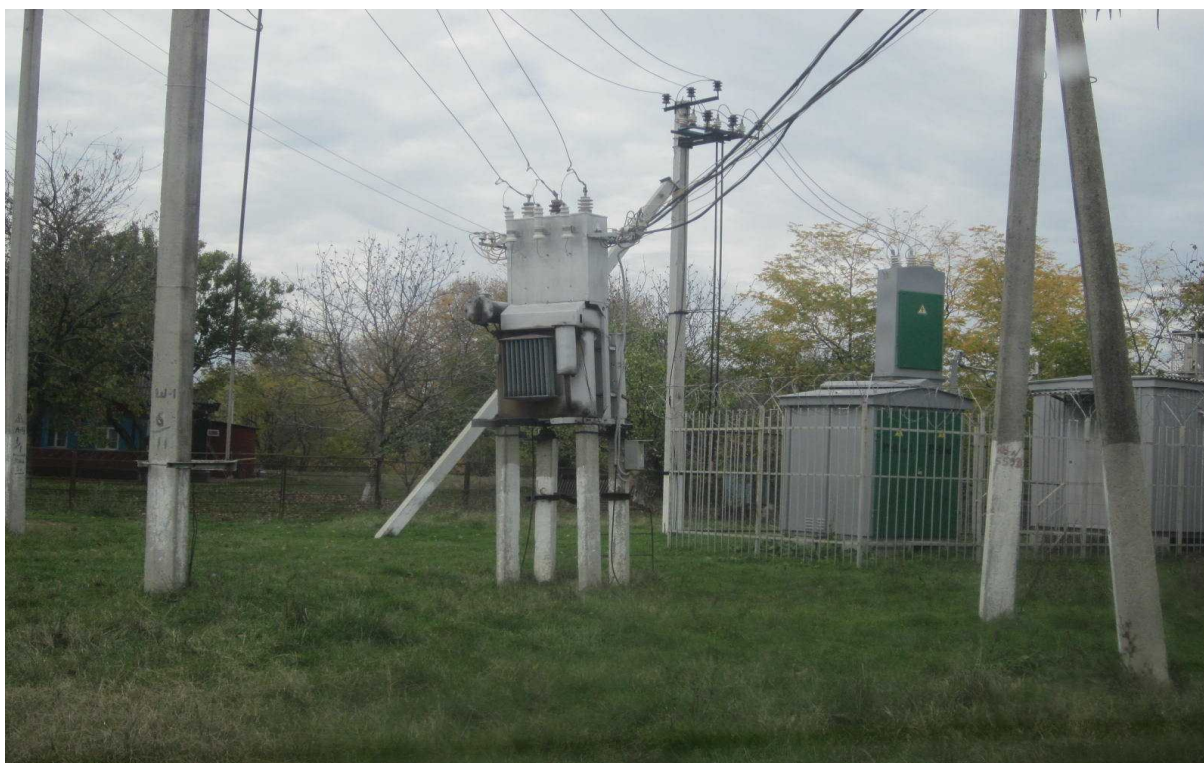
Трансформаторная подстанция-100 кВт. ул.Краснооктябрьская. ТП замаслен. Скрутки. Надписей нет.
