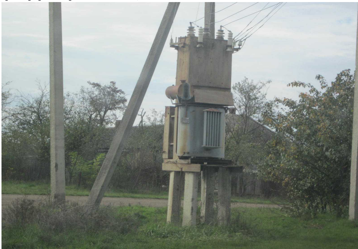
Трансформаторная подстанция – 100 кВт. ТП ржавый. Надписей нет.
