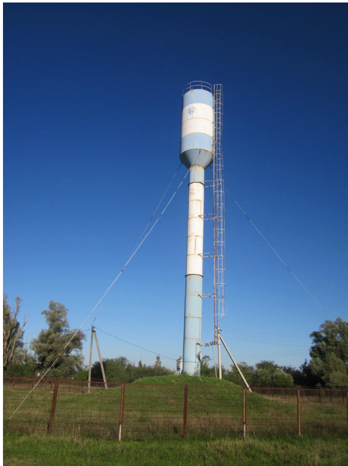
Водонапорная башня. состояние удовлетворительное.
