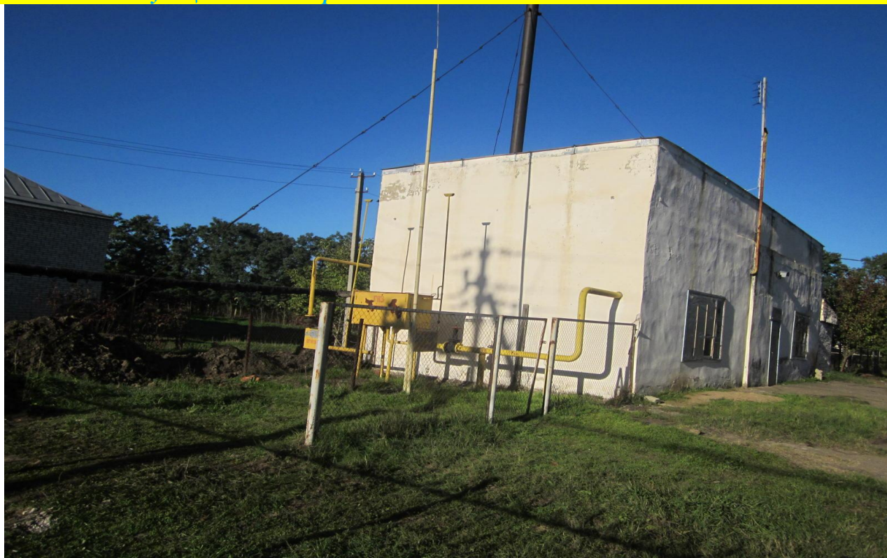
Котельная. Старые котлы.
