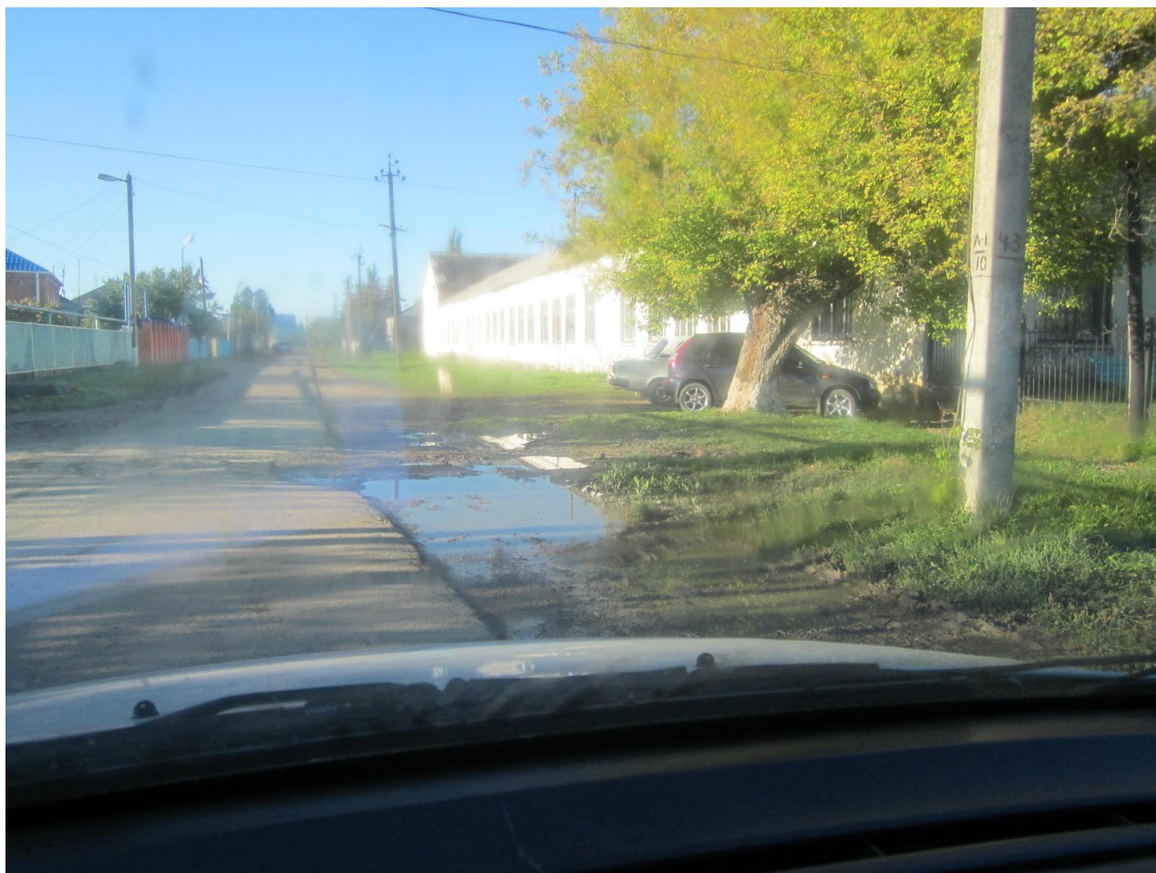
Водоотведение. ул.50 лет ВЛКСМ
